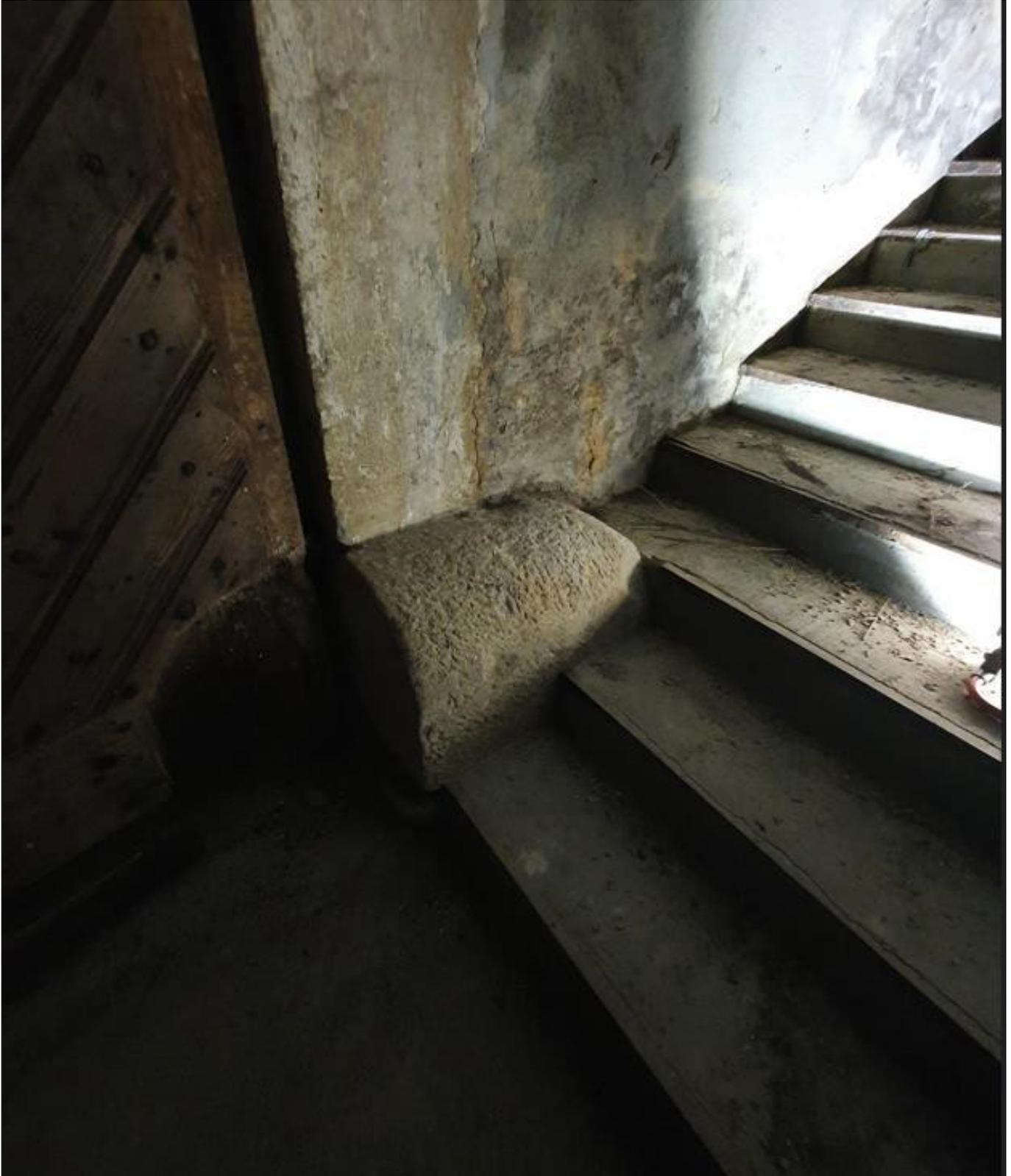
Bild vom teilweise einbetonierten Radabweiser aus Sandstein
