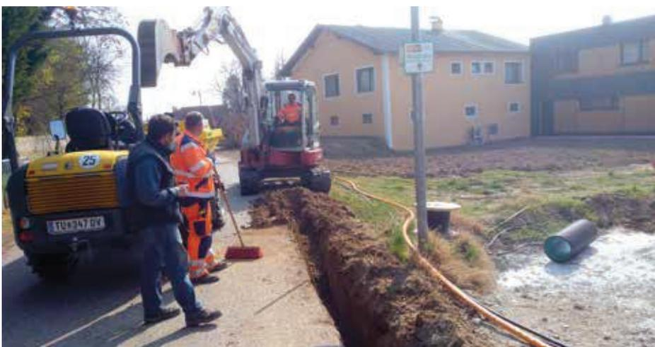
**Breitbandausbau für Thürnthal und Fels Ost:** Die Firma Baumeister Sedlmayer führte im Auftrag der A1Telekom für Thürnthal und Fels Ost Grabungsarbeiten für den Breitbandausbau durch. In diesem Zuge wird auch die Ortsbeleuchtung in diesem Bereich erneuert und auf LED umgestellt.
