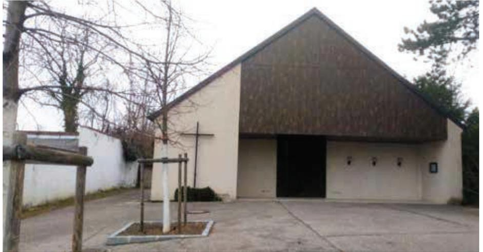
**Sanierung der Leichenhalle in Fels:** Die neue Giebelverkleidung bei unserer Leichenhalle in Fels am Wagram wurde angebracht und die Außenputzflächen neu bemalt.
